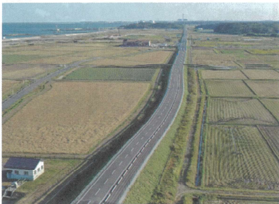
主要地方道相馬亘理線 空撮写真
