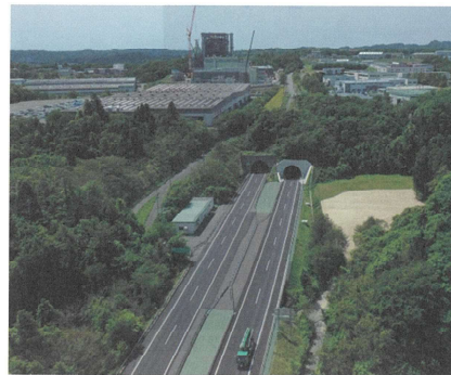
好間トンネルと直上の工業団地
