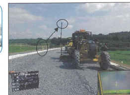
3DMCグレーダーによる敷均し
