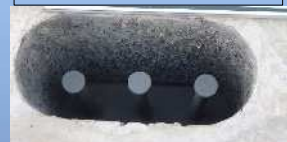
床版に設置したスタッドジベル孔
