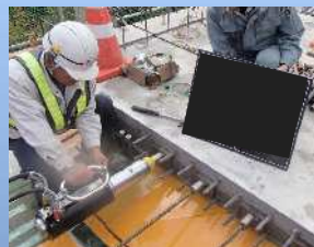
【プレストレス導入により接合する例】
