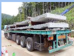
プレキャストP C床板の運搬状況
