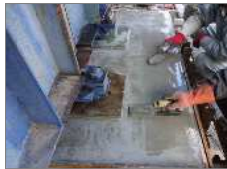
コテによる表面仕上げ
