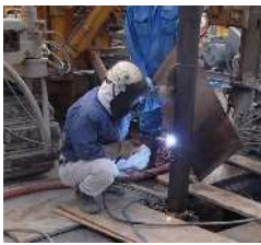
現場での溶接継手 Φ114.3~Φ139.8
