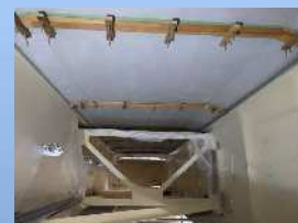
型枠設置状況
