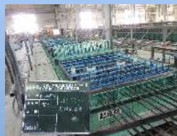
床版製作状況
