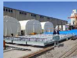
床版保管状況
