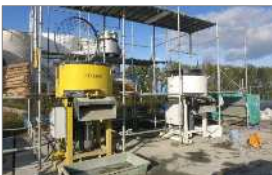
J-ティフコムの施工
