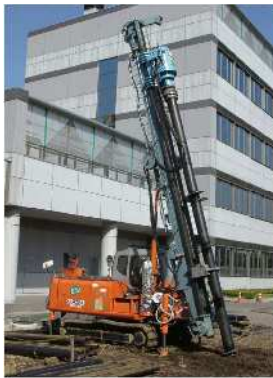
翼部付鋼管（施工状況）
