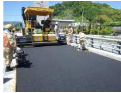
アスファルト混合物敷均し状況
