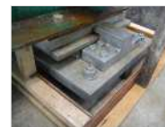
支承取替に合わせて沓座にJ-ティフコムを使用
