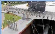
鋼桁とスタッドジベルの接合
