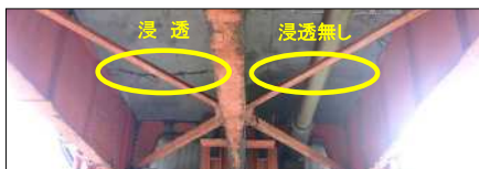
その時床版下面側は、J-ティフコム施工前の側では水の浸透が確認されたが、施工済み側では浸透は無かった。
