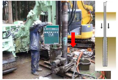
定着部に設計で決められた長さ(1m以上)分の鋼管を再挿入する。
