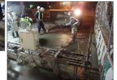
J-ティフコムの敷均し
