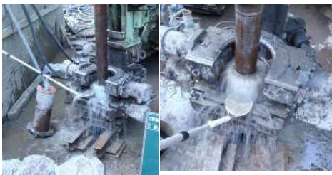
予定深度まで削孔した後、鋼管内を清水にて洗浄し、スライムを排出する。
