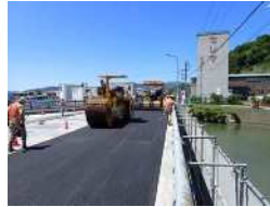
アスファルト混合物転圧状況
