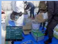
充填材練り混ぜ状況
