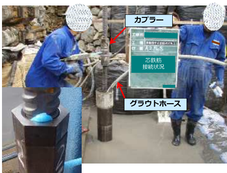
芯鉄筋にグラウトホースを取り付け、棒継手(カップラー)で接続しながら鋼管内に挿入する。
