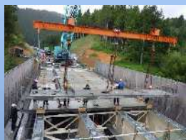
床版架設状況
