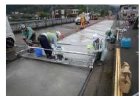
連続打設とシート養生
