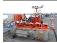
路面ヒーターによる施工前の熱養生
