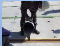
充填材流し込み状況
