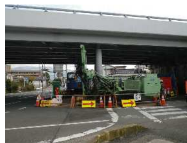
既設橋梁下での杭打ち作業
