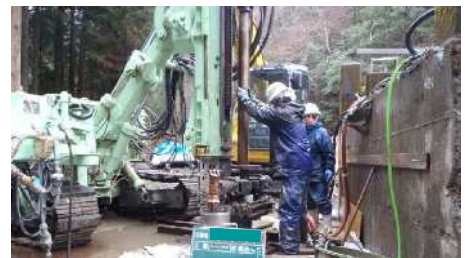
鋼管は残し、インナーロッドを引抜く。
