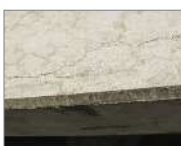
塩害により橋梁のPC桁にひび割れが発生
