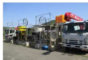
現場での練り混ぜ状況
