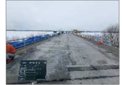
J-ティフコムの施工完了
