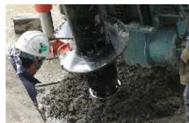
翼部付鋼管（施工状況）
