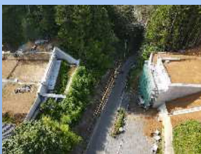
[施工前 現地写真]
