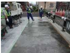
プライマーの塗布
