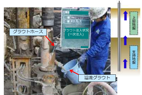
芯鉄筋に沿ったグラウトホースにて鋼管内にグラウトを注入し水と置換する。 溢流グラウトを採用し、比重試験により確実に鋼管内の泥水がグラウトに置き換わったことを確認する。
