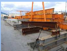
鋼桁を模したH鋼 (現場同様に縦断勾配5.8%)
