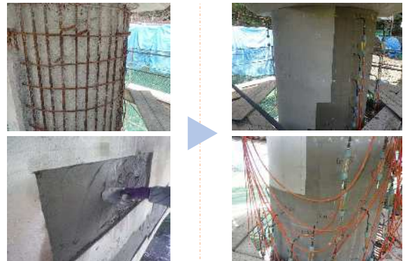
浮き、剥離部にリハビリ断面修復工法
