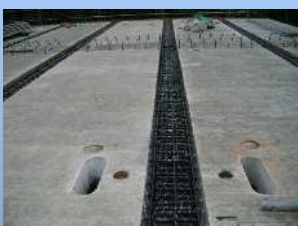
【鉄筋を配置し接合する例】
