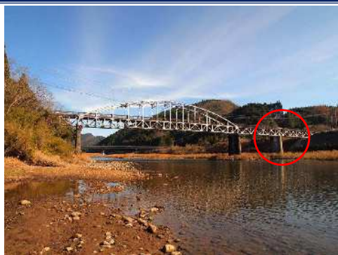
2016年4月(施工後10年経過)健全性維持
