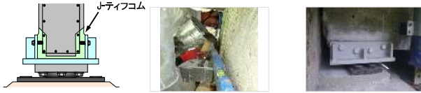
既設コンクリートT桁の支取付部材への充填材として使用した例
